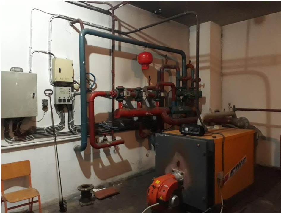
Εικόνα 13: Λέβητας παραγωγής θερμού νερού κτιρίου (πλην σχολείου)
