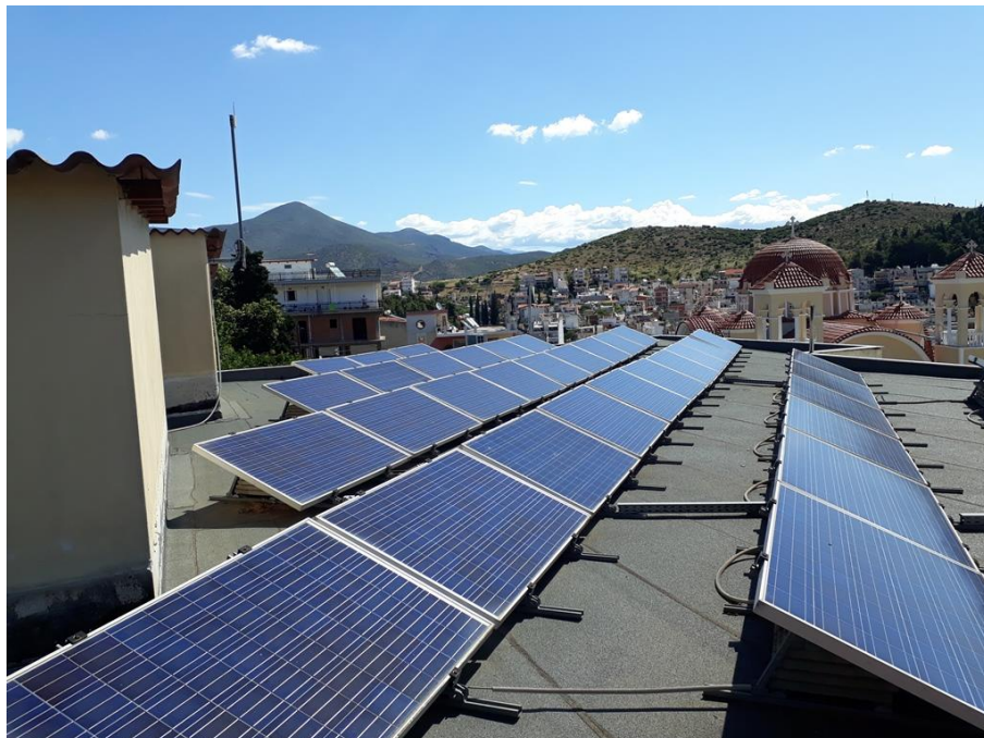
Εικόνα 15: Φωτοβολταϊκή εγκατάσταση δώματος
