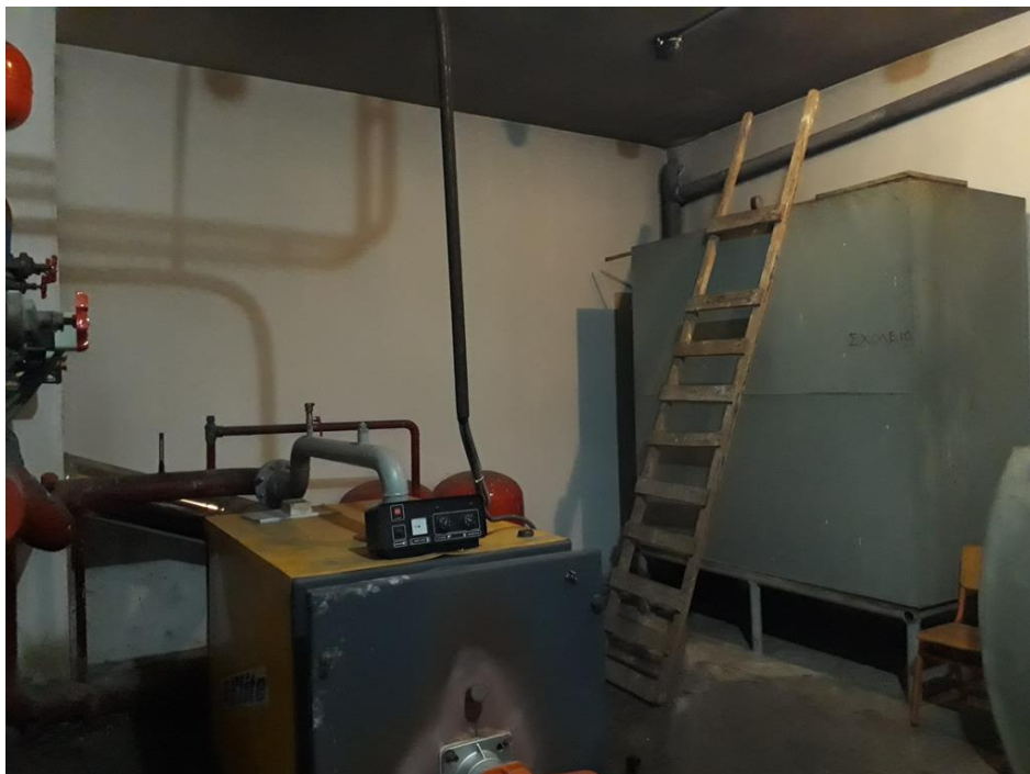
Εικόνα 14: Λέβητας παραγωγής θερμού νερού 13ου δημοτικού σχολείου
